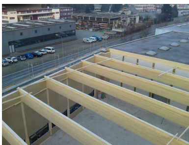
Hallentragwerk vor der Dachelementmontage 2011
