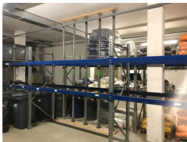
Deckenstützen im Keller eingebaut
