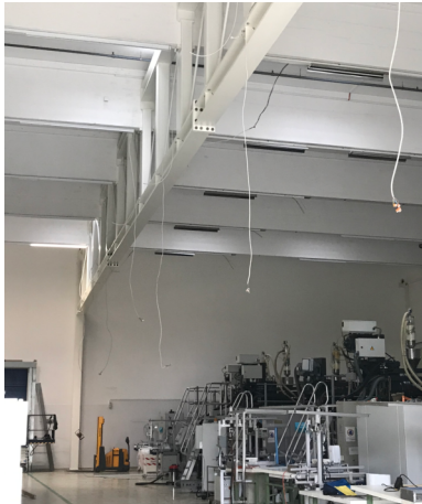
Abnahme des eingebauten Fachwerkes
