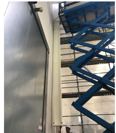
Für den Einbau der Stützen musste das Dach geöffnet werden
