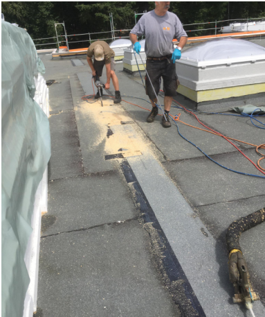
Bohren der Löcher, Einbauen der Gewindestangen
