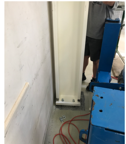
Stützenfuss: Nach dem Einbau wird dieser noch mit Spezialmörtel untergossen
