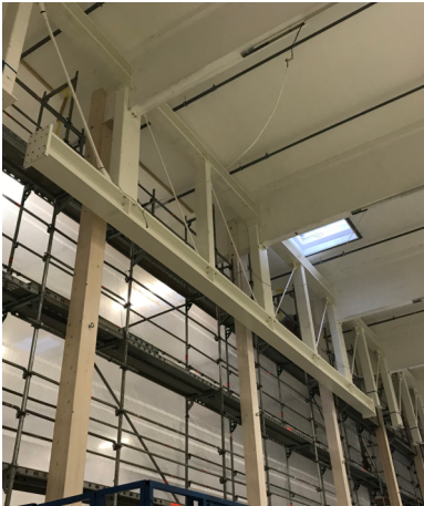
Fachwerk teilweise eingebaut, Mittelteil des Untergurtes ist montiert
