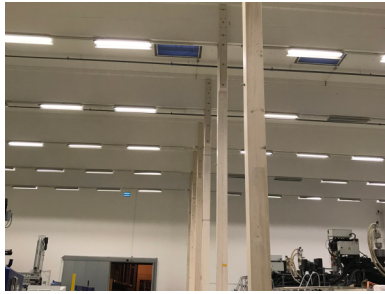
Holzstützen eingebaut
