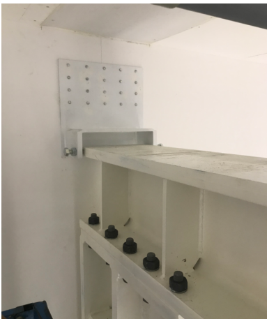
Stabilisator des Obergurtes ist montiert. Das war die letzte Handlung am Tragwerk
